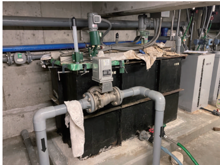
既設のSS製内面PVCライニング槽
